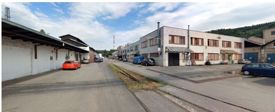
prostory kolem výhybek v areálu
