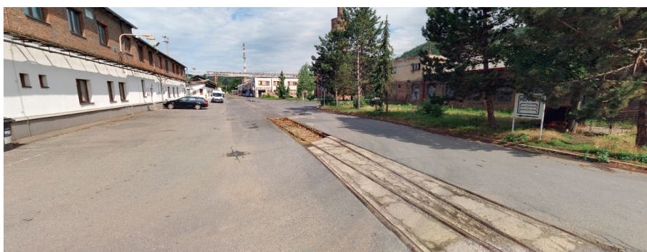
prostory kolem výhybek v areálu v blízkosti vjezdu do areálu
